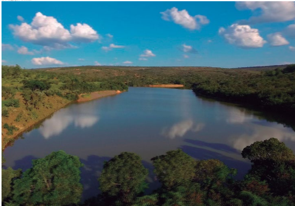
| Barragem Rio do Vale, em Montes Claros (MG).
