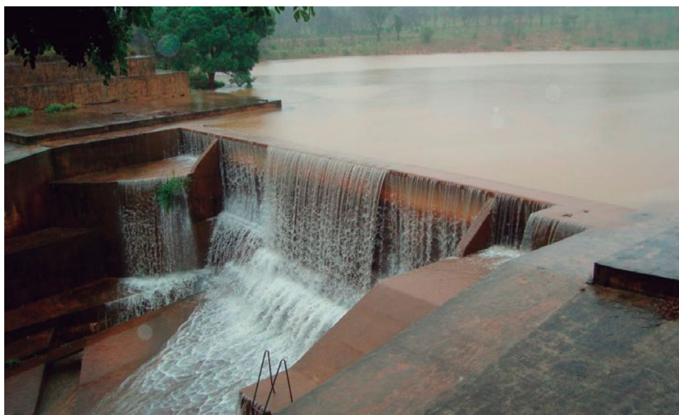
| Barragem Rio do Vale, vertendo em período chuvoso.
